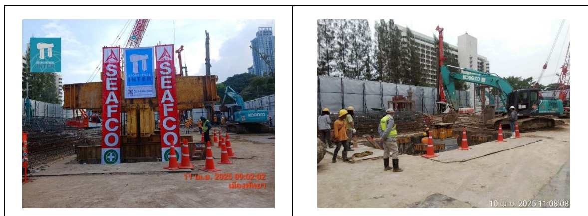
รูปที่ 13 เส้าเข็มแบบเจาะ
