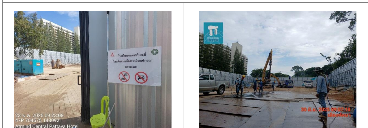
รูปที่ 8 พื้นที่ล้างล้อรถ และเจ้าหน้าที่ทำความสะอาดล้อรถบรรทุก
